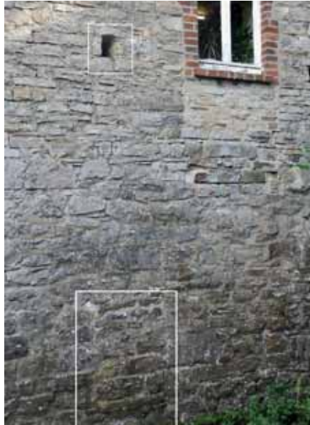
Blick auf die zugemauerte Öffnung der Mühlradachse und oben die Mauernische für den Haltebalken der Gerinnebretter.
