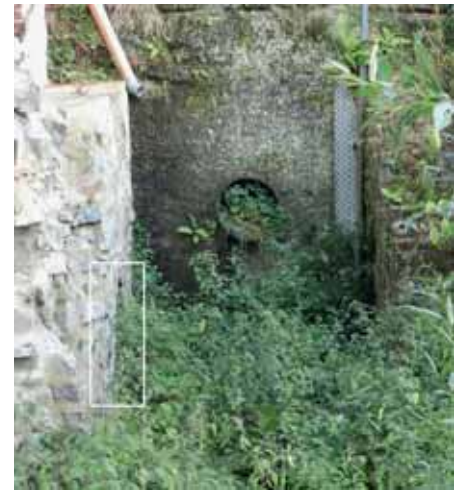
Wasserzuführrohr, links an der Bruchsteinmauer Mauerdurchführung der Mühlradachse und Blick in den Untergraben
