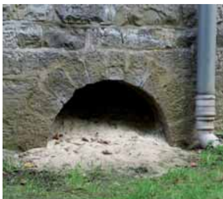
Maueröffnung zur Durchführung der Mühlradwelle
